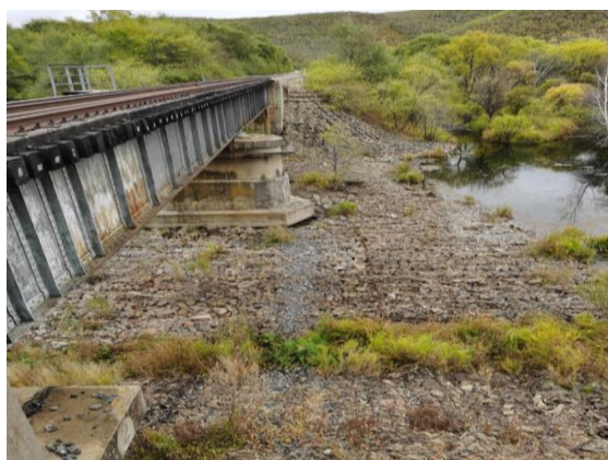
K246+667 洮儿河 8 号桥现场照片
