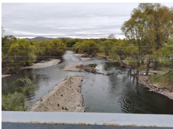
K246+168 洮儿河 9 号桥现场照片
